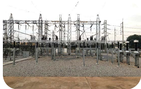
โครงการก่อสร้างเพิ่มเบย์ 115 เควี สถานีไฟฟ้าห้วยทะเล จังหวัดนครราชสีมา
