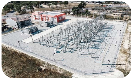
โครงการก่อสร้างสถานีไฟฟ้าแรงสูง 3 กับปรับปรุงสถานีไฟฟ้าแรงสูง 1 และ 2 อำเภอสตึก จังหวัดชลบุรี
